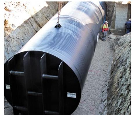
FTW®-Trinkwasserspeicher: Setzen eines Trinkwasserspeichers (DN 2700) inkl. Armaturenkommer
